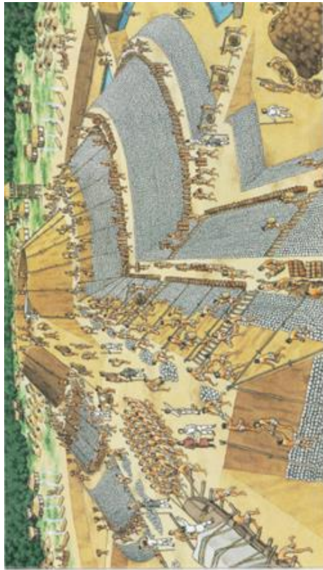
②古墳づくりのようす (想像図) 古墳づくりからは、当時のすぐれた土木技術がわかります。
